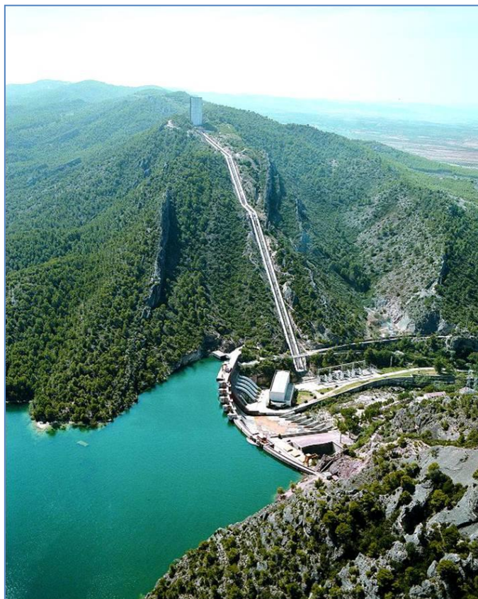
Fotografía 6. Embalse y central de Bolarque y tuberías del trasvase Tajo-Segura
