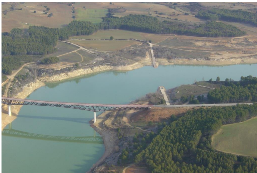
Fotografía 8. Nuevo puente de Alcocer y antiguo puente sumergido
